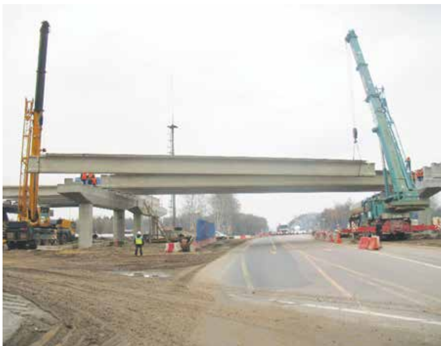
Монтаж балок путепровода на ПК-6 Орехово-Зуево
