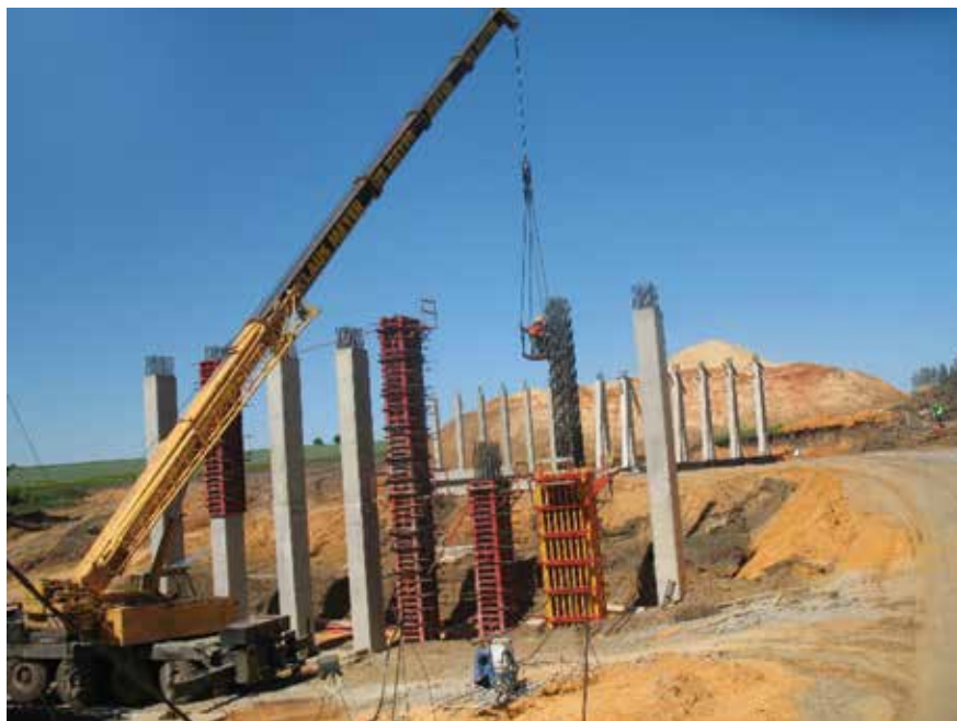
Возведение опор моста на обходе села Яркино Липецкой обл.
