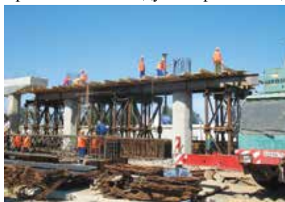
Строительство опор на ПК-6 на обходе Орехово-Зуева
