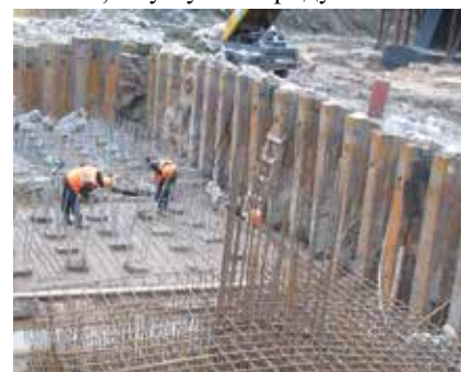
Строительство фундаментов опор путепровода на обходе Орехово-Зуева
