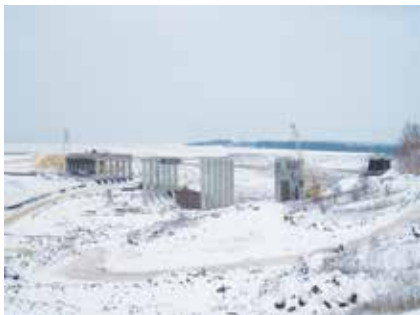
ПК-177 на обходе Ельца
