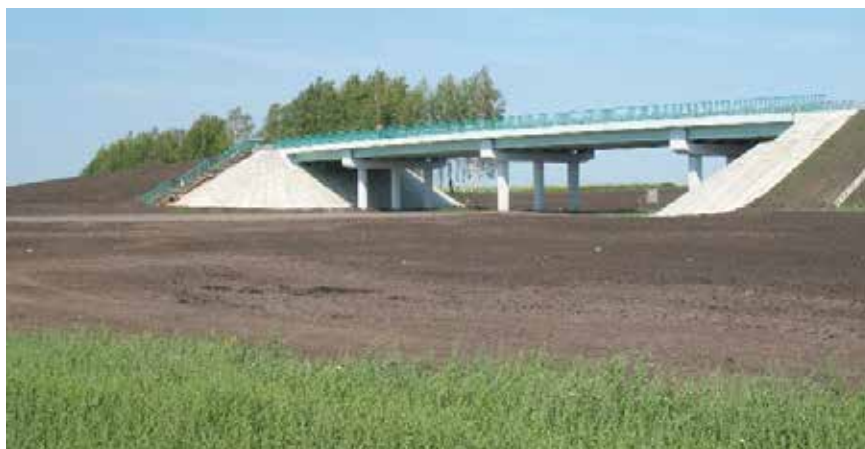
ПК-333 на обходе Ельца
