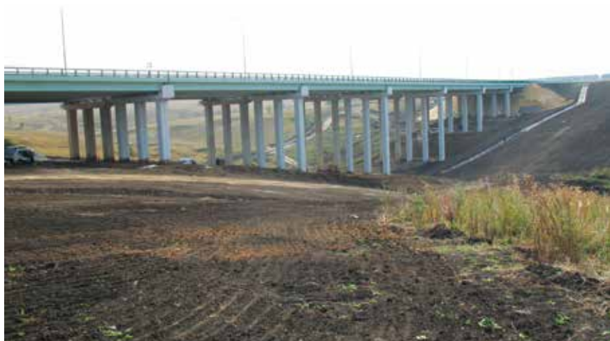
ПК-172 на обходе Ельца
